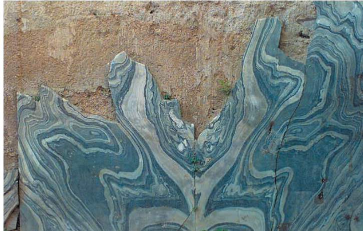
Abb. 4: Sockelzone der Marmorwandausstattung in der SW-Ecke des Raumes mit in situ erhaltenen, axialsymmetrisch versetzten Orthostatenplatten aus Cipollino verde (Photo A. Schifflleitner)
